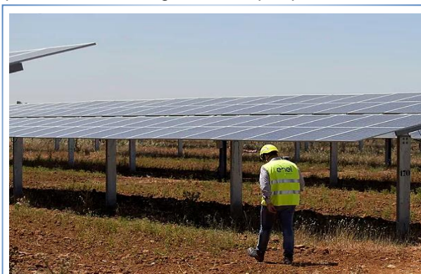
Un trabajador, en la planta fotovoltaica de las Corchas, en Carmona (Sevilla).
