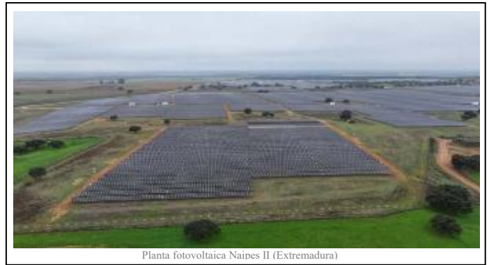
Planta fotovoltaica Naipes II (Extremadura)
