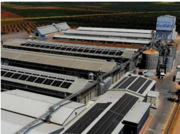
**MASPV** ha culminado la ampliación de la **sexta planta fotovoltaica** en las instalaciones de **Huevos Guillén** en Almendralejo (Extremadura), dentro de un proyecto conjunto iniciado en 2022. La nueva planta cuenta con **434,32 kWp de potencia pico** y una superficie instalada de **1.923 m<sup>2</sup>**, incorporando módulos de alta eficiencia **LONGY HiMOX 6 MAX**, sistemas de anclaje **SUNFER 07H** e inversores **Huawei**.
